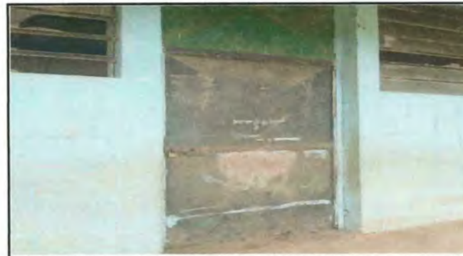
FOTO. Instalacion de puerta de metal de 1.01mst x 2.07 mst 4
