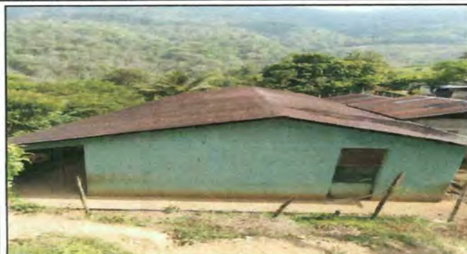
FOTO. Sustitucion de lamina normal por lamina troquelada calibre 26 aluzinc 1
