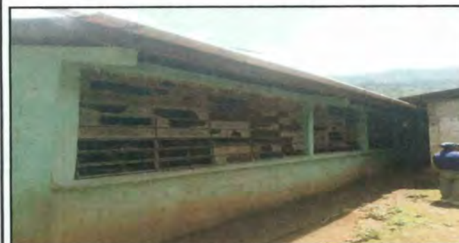
FOTO. Mejoramiento de canales y bajada de agua pluvial 5
