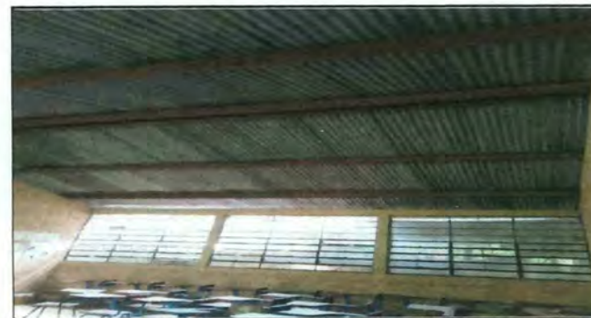
FOTO. Mantenimiento de Estructura de metal 6
